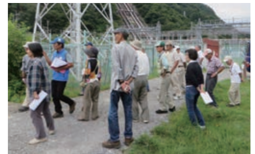
八ツ沢発電所
