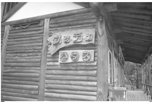
流域材で小学生も参加してつくったログハウス。玉川小学校
