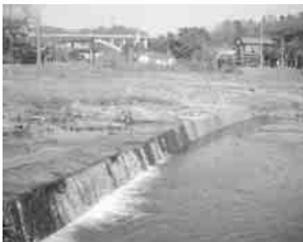
串川の床止工
