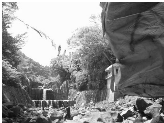
田原の滝(クレーンつり上げ)
