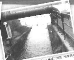
桂川・相模川源流 山中湖水門
