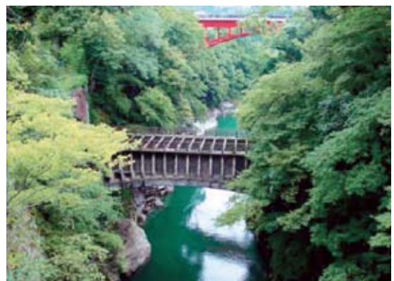
ハッ沢発電所第一号水路橋（国重要文化財）
