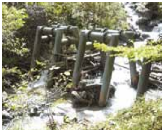
仏沢スリット治山ダム
