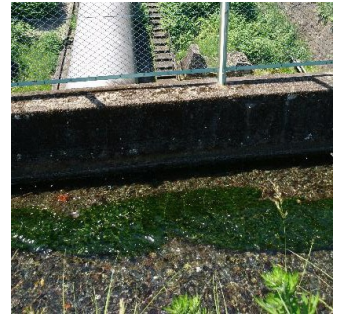
写真④ 鹿留発電所周辺
