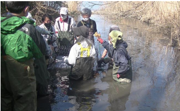
組み立てた石倉カゴを川底に設置。
